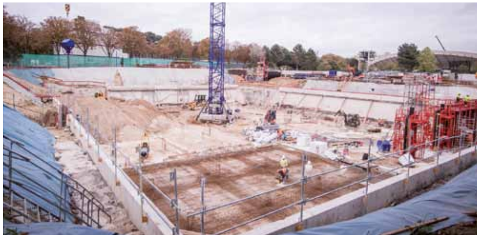
Construction du court 14
