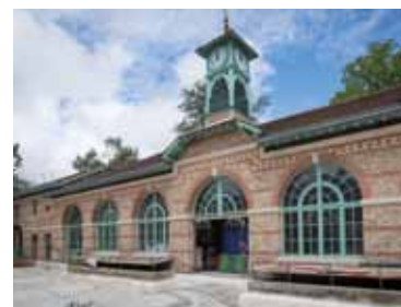
Restauration des bâtiments en meulière
